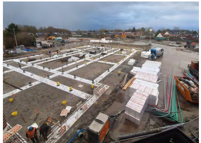
Overzicht bouwlocatie Wiemersheerd
